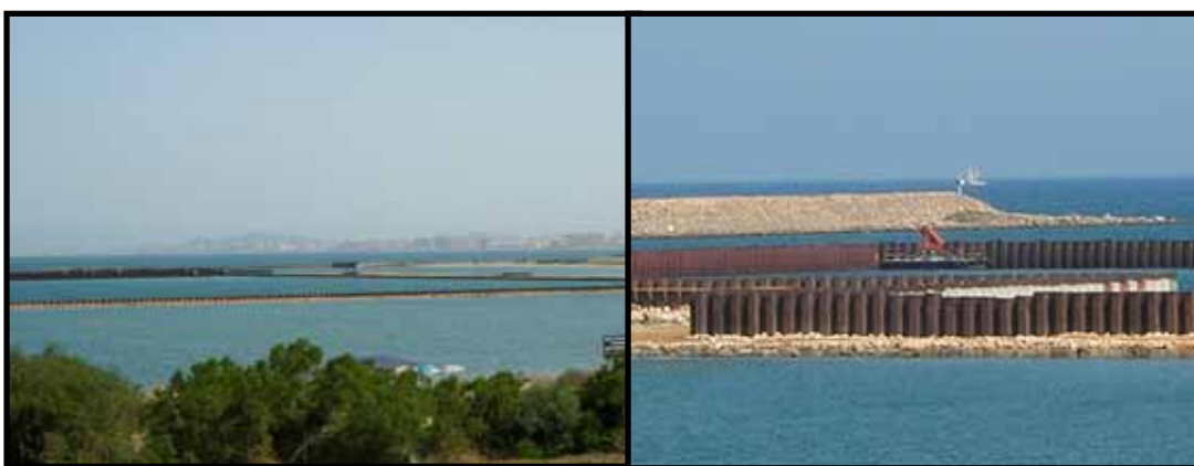
Figura 6.8.3: Obras del polémico Puerto Mayor en La Manga del Mar Menor (San Javier). En la imagen de la derecha se observa con más detalle.
