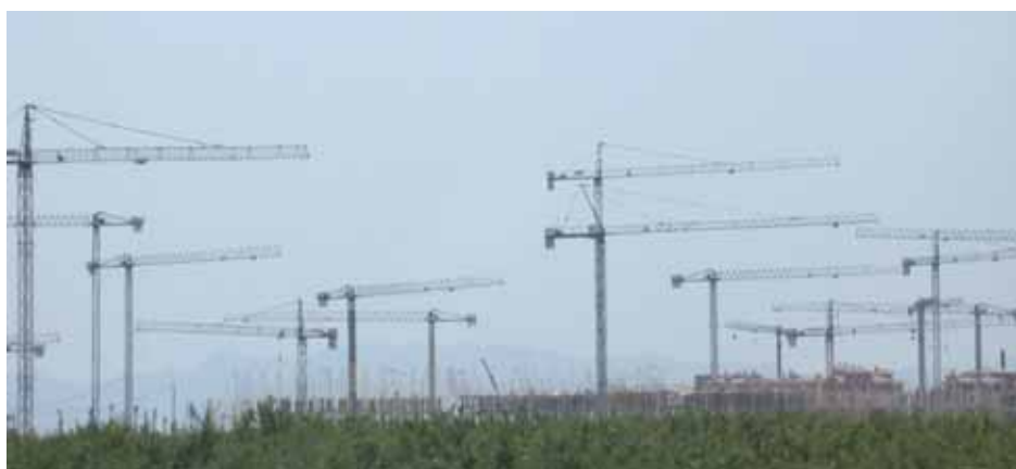
Figura 6.5.1: Grúas realizando la urbanización La Torre (Polares World) en el termino municipal de Torre Pacheco . Julio 2005.
